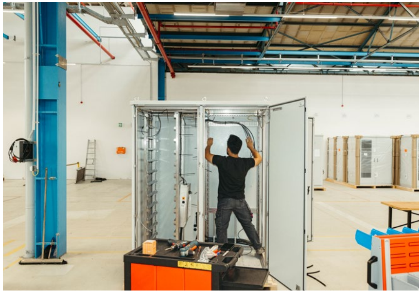
Saubere Technik: Ein Mitarbeiter bringt die Verkabelung in einem Batterieschrank an
